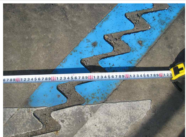
신축이음 이동량 측정
