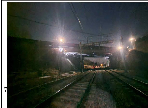
작업전경 - 경춘선 통제(야간)
